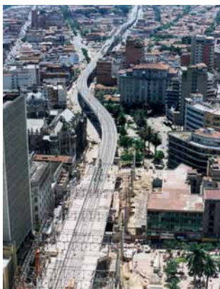
Gráfico 10. Construcción del viaducto sobre la Plazuela Nutibara. Biblioteca Metro. Bello.
