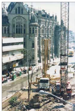
Gráfico 6. Viaducto en construcción. Biblioteca del Metro. Bello
