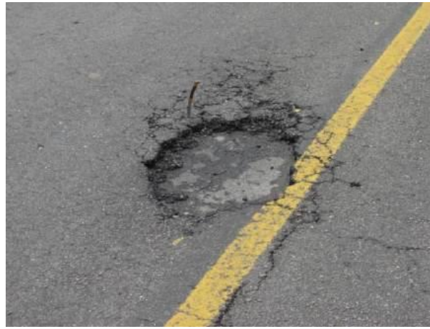
Figura 10. Descascaramiento
