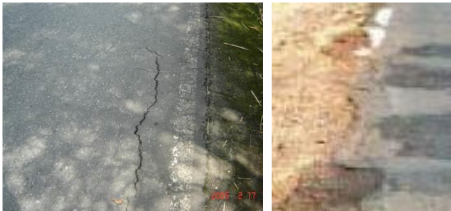
Figura 17. Desintegración de bordes
