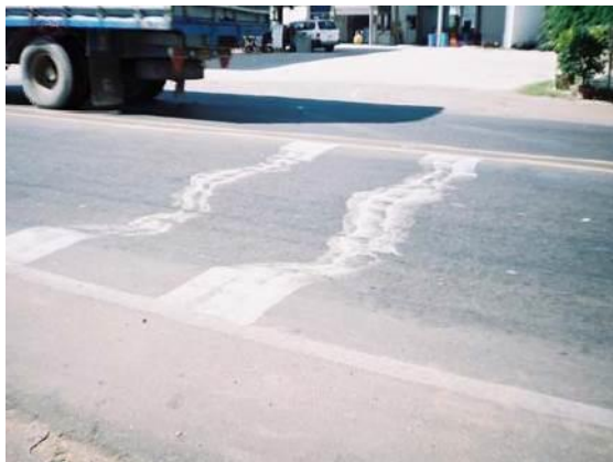
Figura 8. Ahuellamiento
