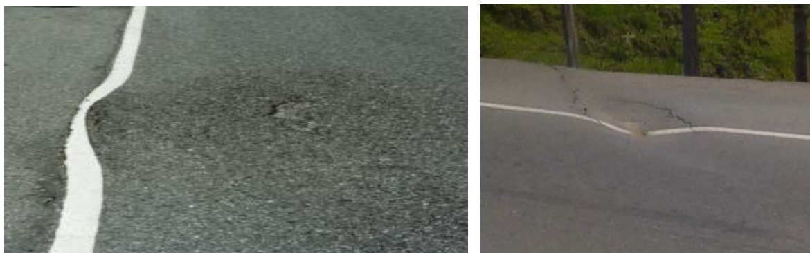
Figura 13. Hundimiento
