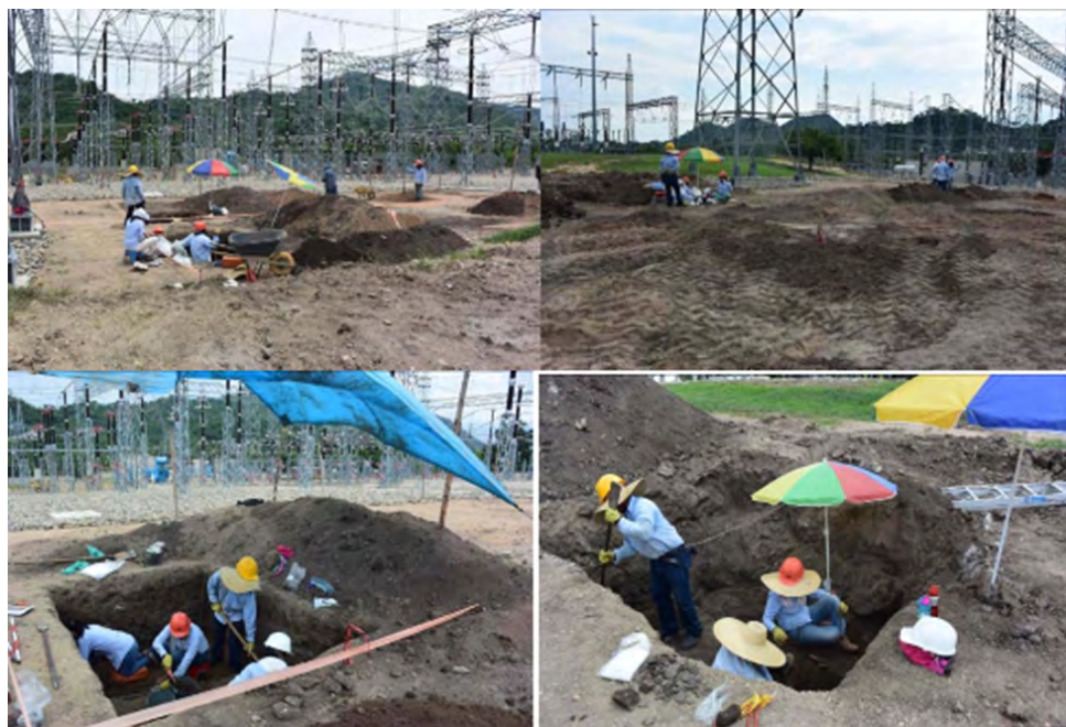
Figura 2. Excavaciones en el cementerio indígena subestación Copey
