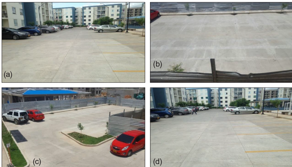
Figura 25.11. Pavimento construido. Urbanización Torres de Mayales, Valledupar
