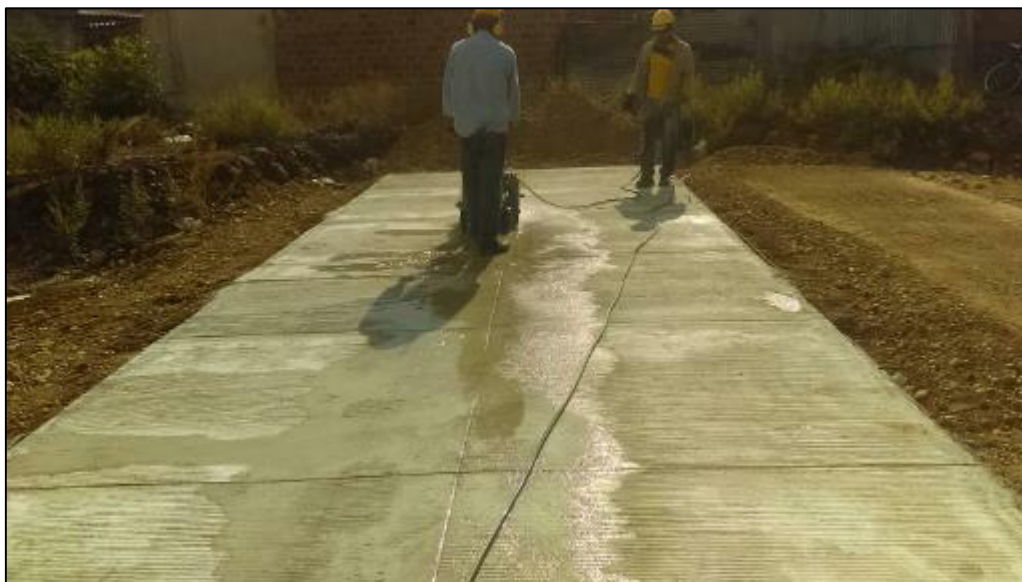
Figura 25.6. Secuencia de construcción. Corte de juntas
