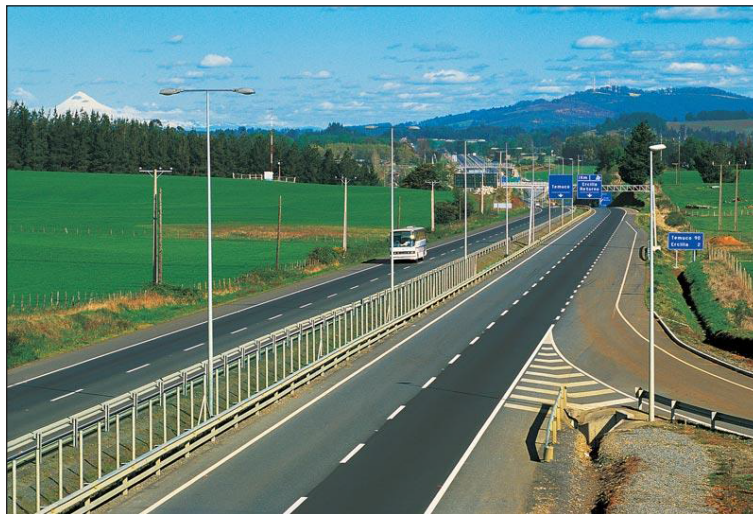
Figura 7.9. Ruta 5 Sur (Chile). Tramos importantes de la carretera Panamericana en Chile se han realizado con SMA
