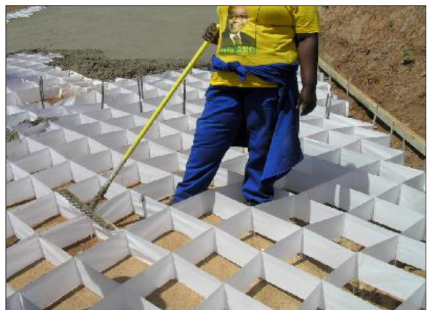
Figura 24.1. A la izquierda: geocelda rellena con material granular. A la derecha: geocelda rellena con concreto
