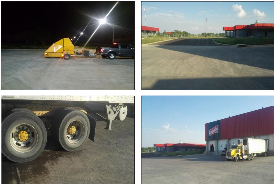
Figura 25.17. Pavimento construido. Fazenda
