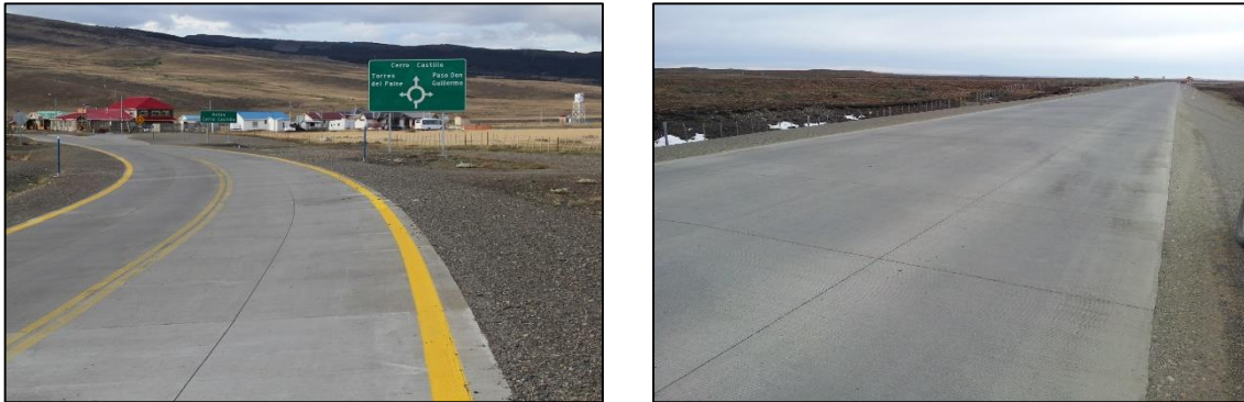
Figura 25.5. (a) Ruta 9: Cueva Milodon, Cerro Castillo, 9 cm, construido en 2009; (b) Cerro Sombrero, Onaisin, 14 cm con fibra. Construido en 2012
