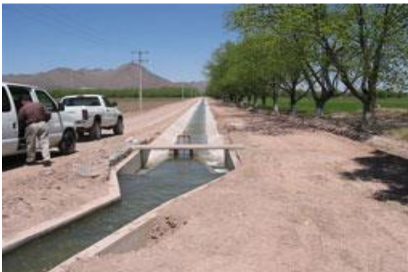
Figura 11. Canales revestidos y sin revestir
