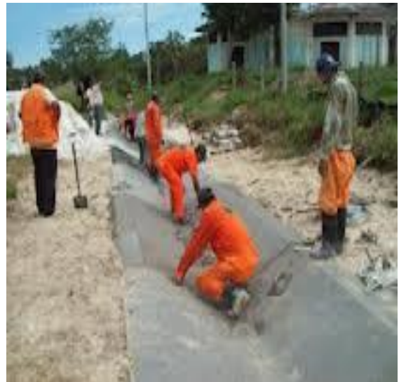
Figura 8. Cuneta revestida
