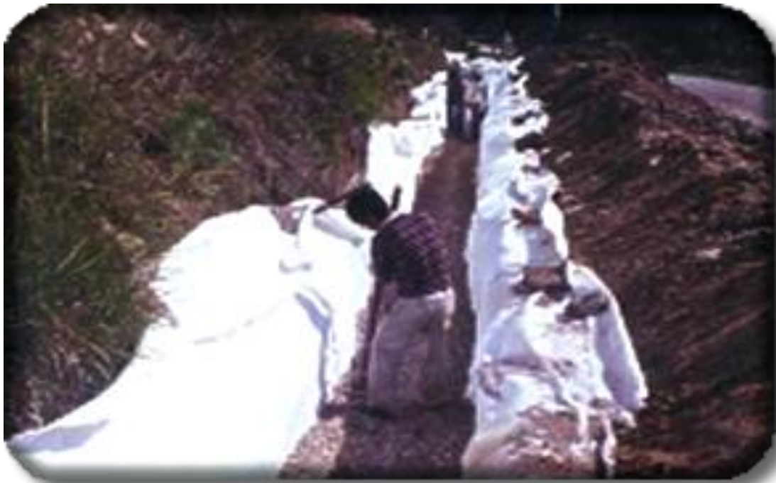
Figura 13. Construcción de filtros
