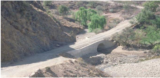
Figura 10. Alcantarillas
