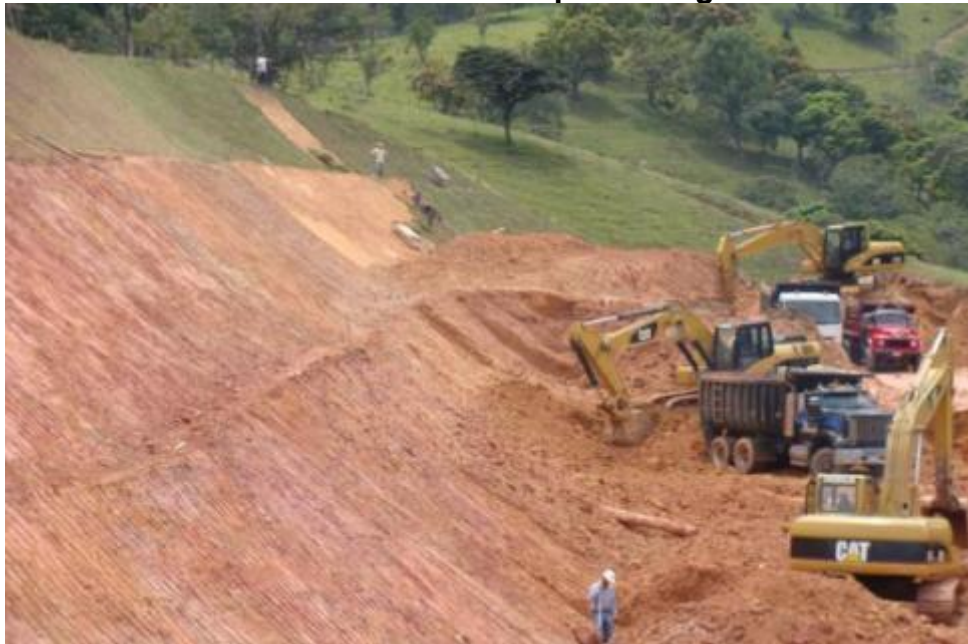
Fotografía 1. Disposición de Maquinaria en la excavación de la Vía Interna en Valle Sur – Municipio de Itagüí
