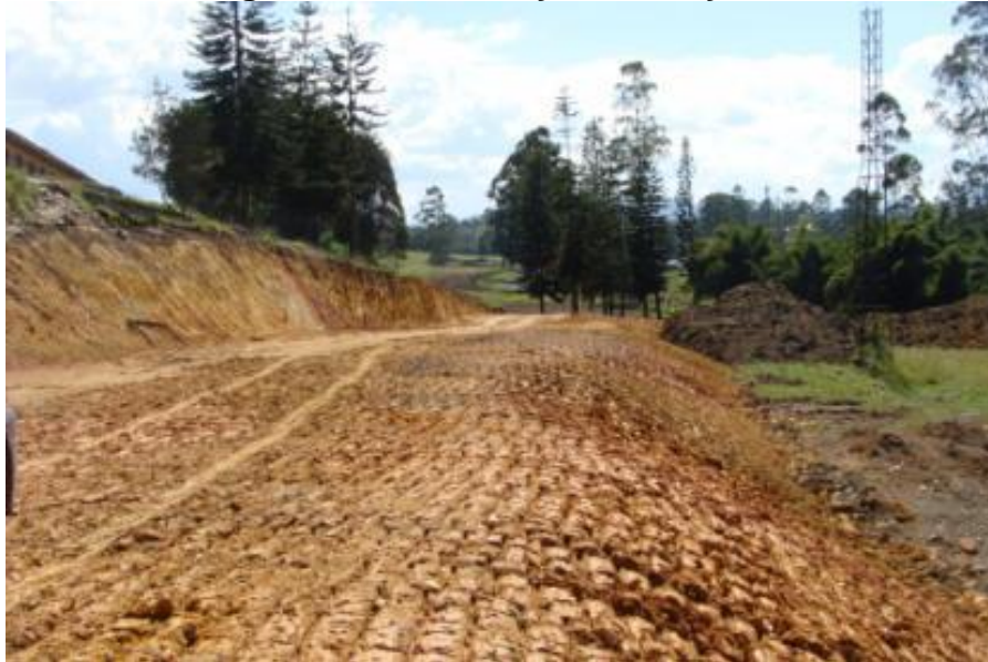
Fotografía 11. Corte y Lleno Adyacente
