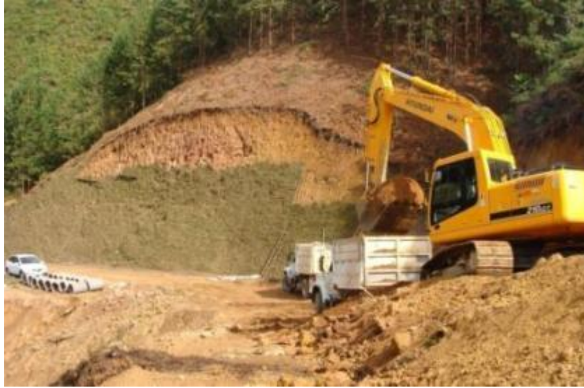
Fotografía 13. Volqueta al mismo nivel de sustentación de la Excavadora
