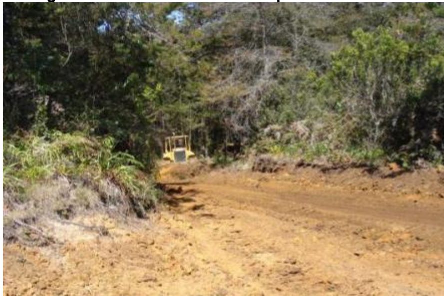
Fotografía 2. Desmonte en zonas planas con Bulldozer
