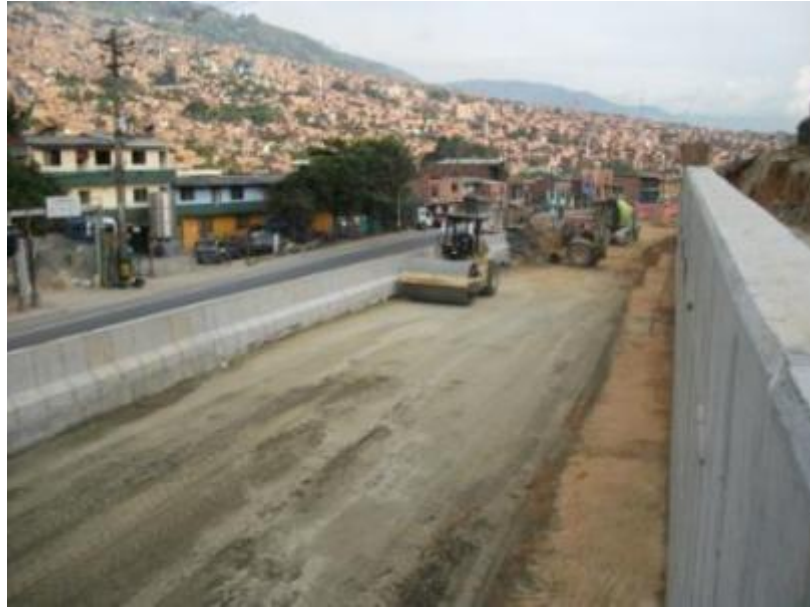
Fotografía 29. Compactación de Material granular en la vía Solla - Tricentenario
