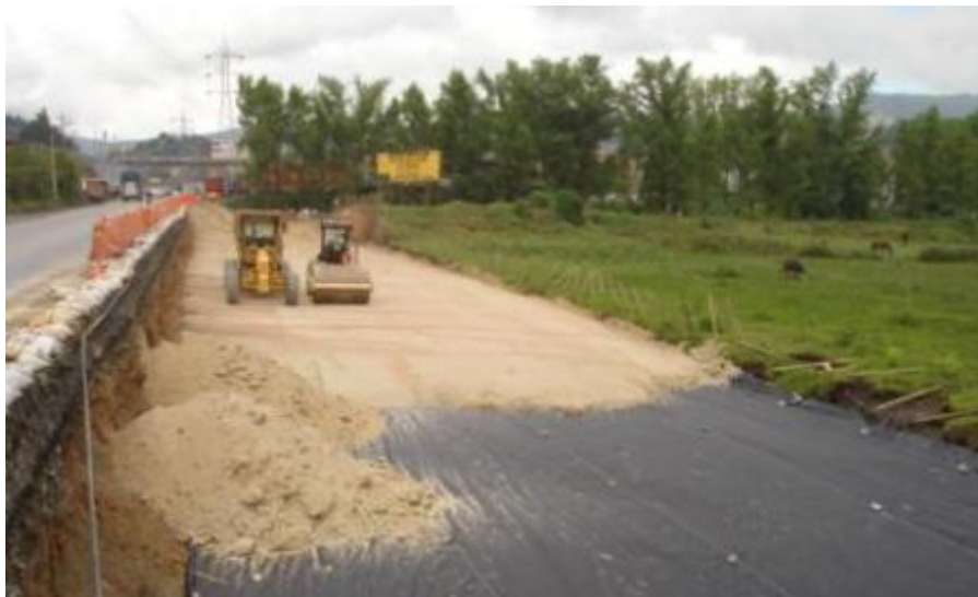
Fotografía 21. Conformación de terraplén K2+500 Vía Ancón sur – Primavera
