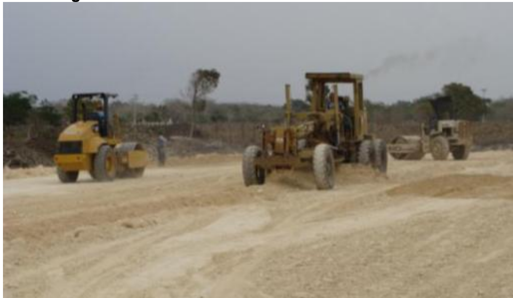
Fotografía 17. Nivelación del terreno con Motoniveladora
