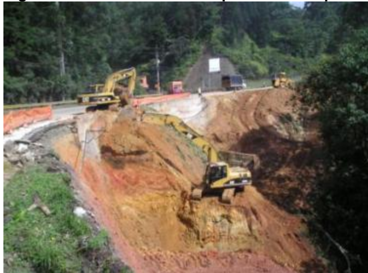
Fotografía 14. Excavación con proceso de repaleo
