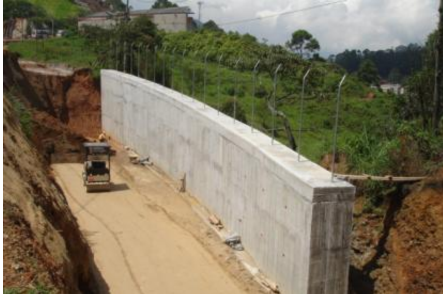
Fotografía 20. Construcción de terraplén en zonas montañosas
