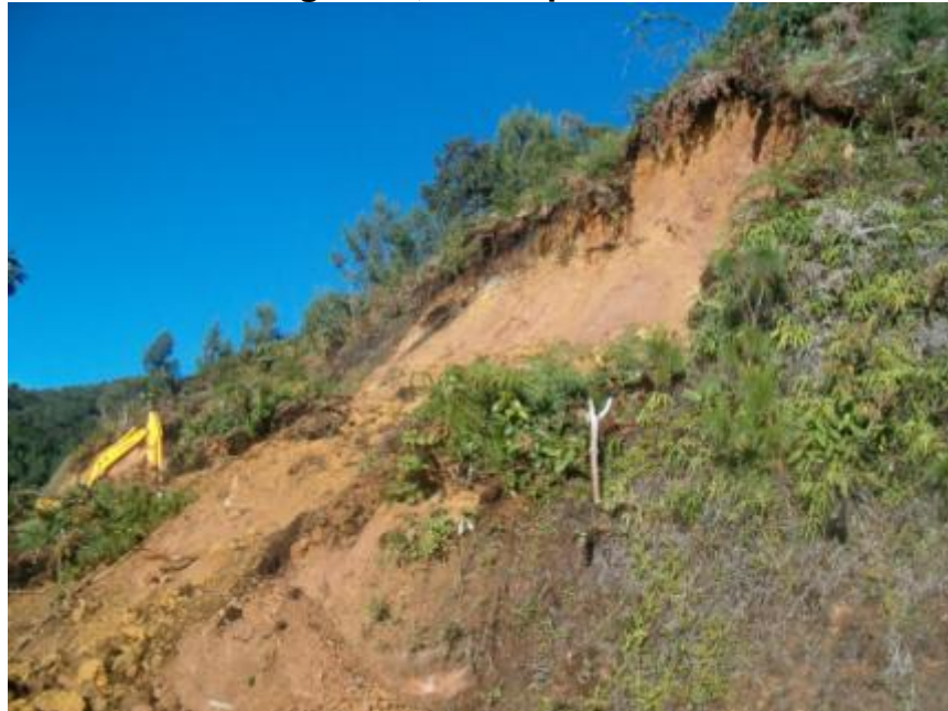
Fotografía 4. Desmonte en zonas escarpadas, Vía Interna de la Parcelación Sierra grande, Municipio del Retiro
