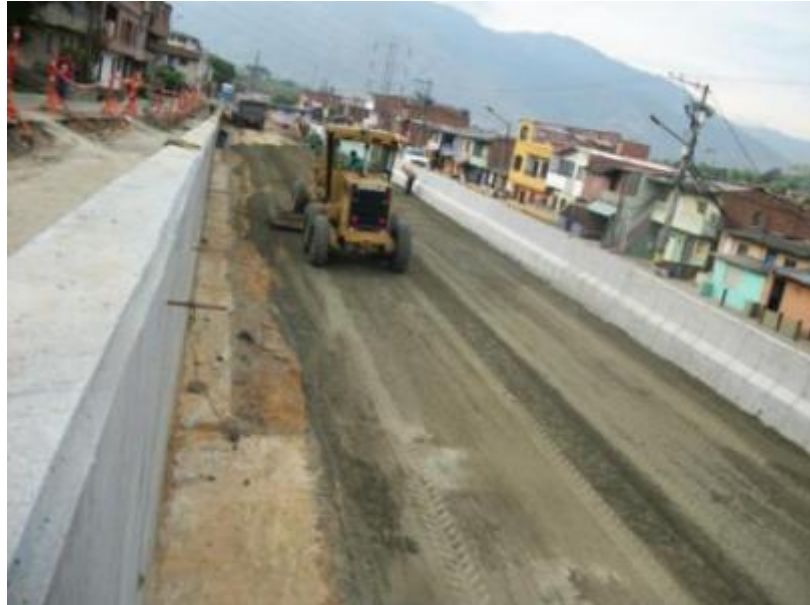
Fotografía 28. Extendido de material granular en la doble calzada Solla - tricenenario
