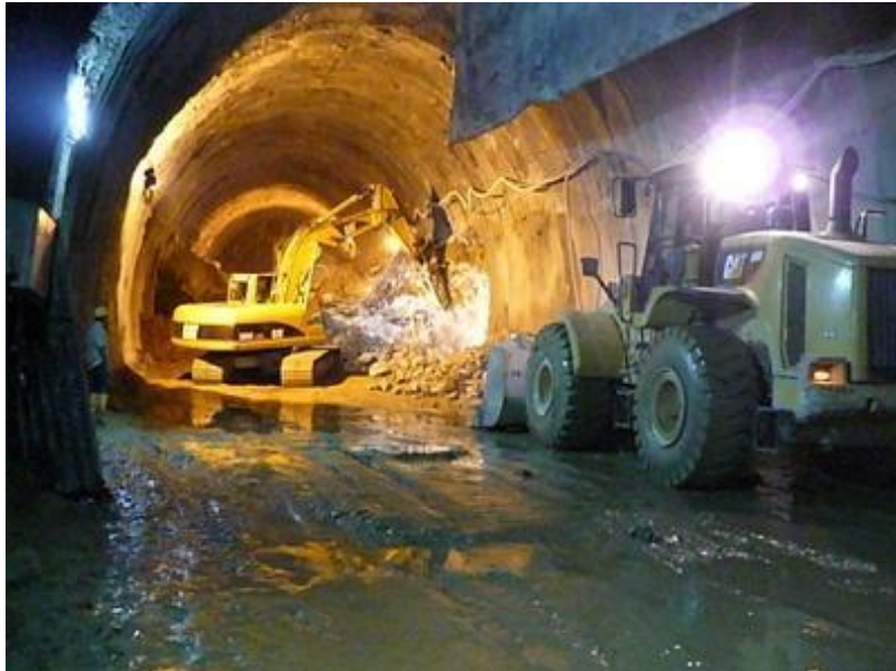
Fotografía 7. Excavación en túneles - Excavación túnel Piloto de La Línea
