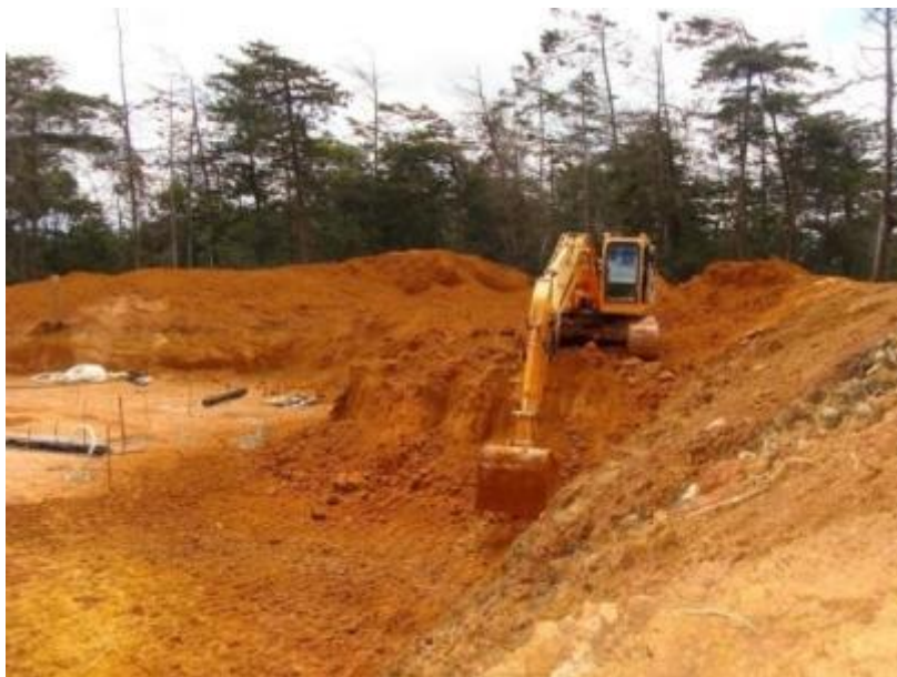
Construcción Comfama – Parque Arvi Corregimiento Santa Elena
