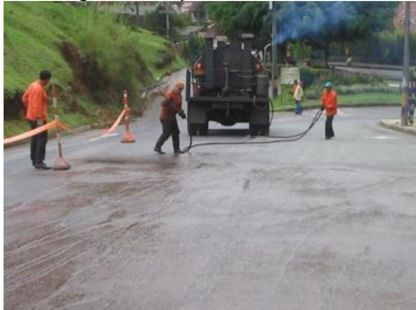
Fotografía 30. Repavimentación calle 5 sur
