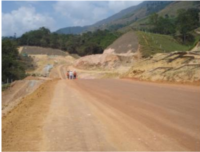
Fotografía 18. Sellado de la subrasante en la doble calzada Bello - Hatillo
