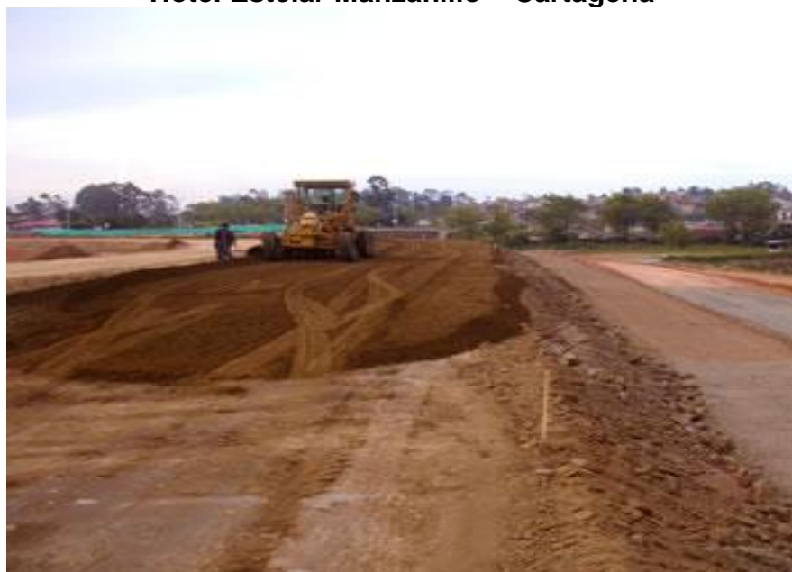
Fotografía 22. Extendido de material con Motoniveladora Vía de Acceso Hotel Estelar Manzanillo – Cartagena
