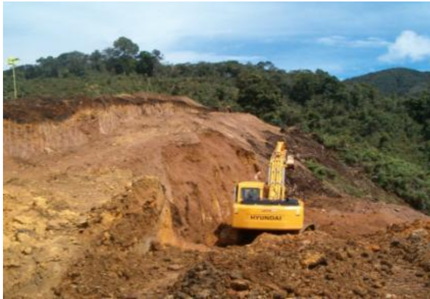
Fotografía 6. Moldeo del suelo con Excavadora
