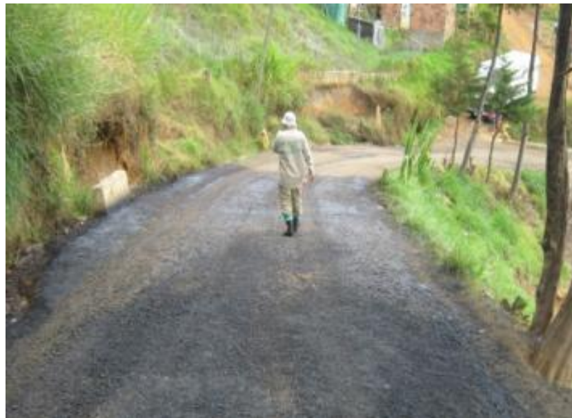
Fotografía 31. Imprimación en vías rurales, Corregimiento San Antonio de Prado
