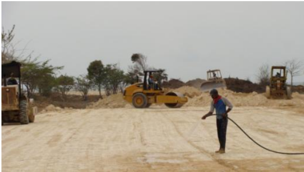
Fotografía 19. Construcción de terraplenes
