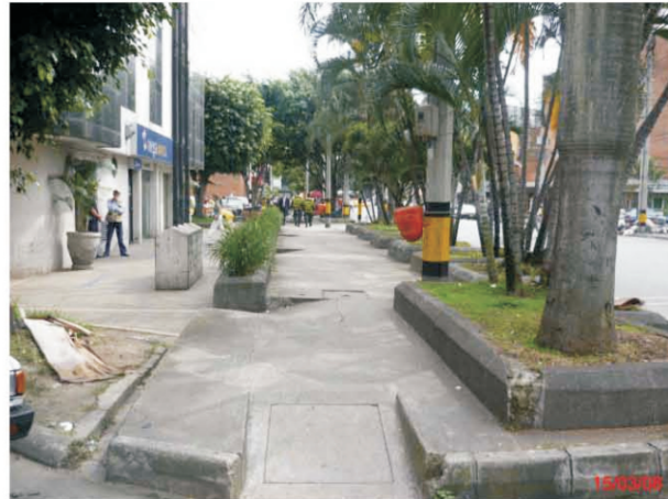
Fotografía 3 Discontinuidad y obstáculos en andenes, carrera 70 con calle 43
