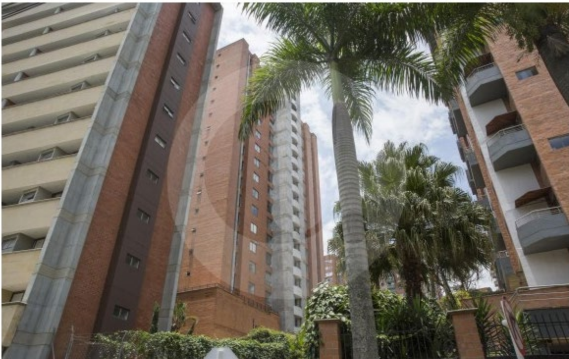
El edificio Bernavento, en la Loma de los Bernal, el más reciente caso de fallas que hablan de un asunto ético. FOTO EDWIN BUSTAMANTE
