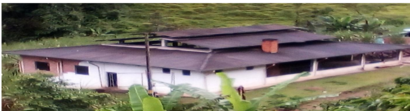
Figura 4. Instalaciones del trapiche comunitario de San Pascual.
