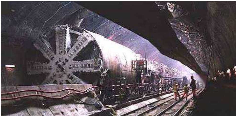
Imagen 15. TBM usada en el Canal de la Mancha.
