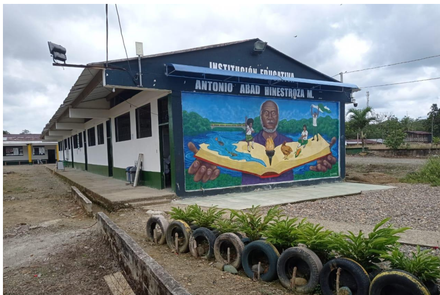
Figura 1. Fachada principal de la Institución Educativa Antonio Abad Hiestroza
