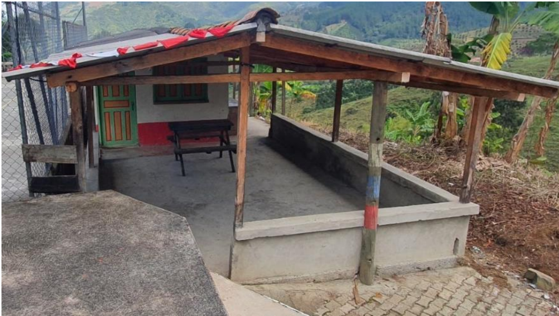
Figura 69. Cubierta de comedor. CER Avelino Marín B.
