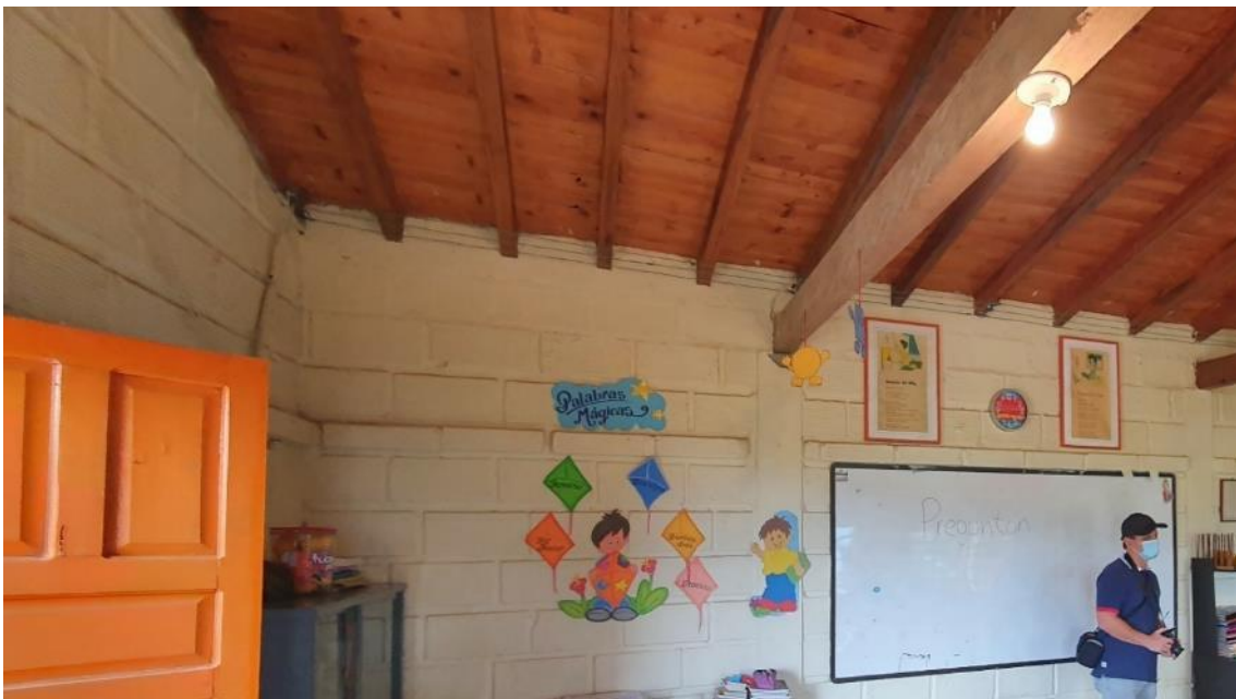
Figura 72. Interior de aula. CER La Pradera
