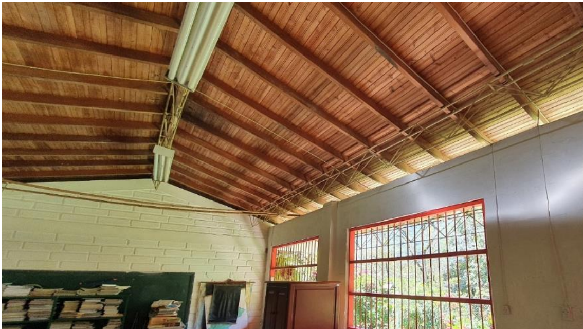
Figura 76. Apoyo de cubierta. CER La Cascada Normal
