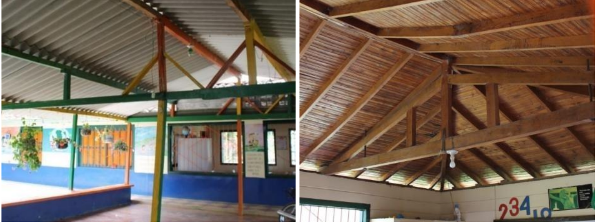
Figura 23. Estado de cubierta del CER Estrella Vieja (ID 4)
