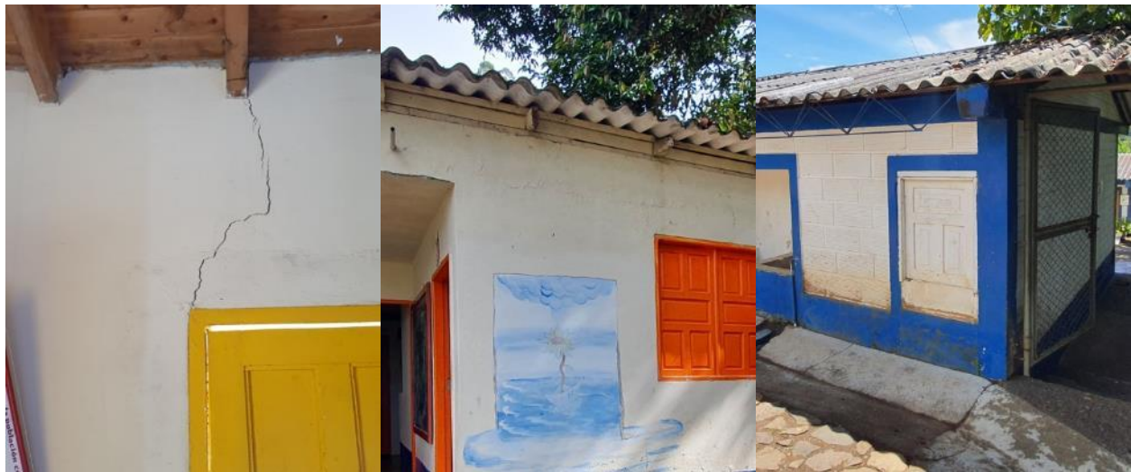
Figura 84. Parámetro de Conexión de la cubierta con la estructura. Imagen de elaboración propia
