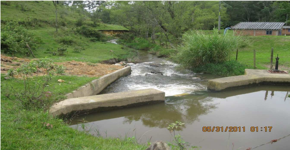
Foto Bocatoma La Barbacoas
