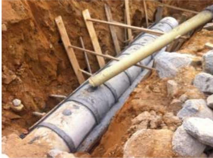
Es recomendable que los canales sean metálicos o estén recubiertos para facilitar el desplazamiento del concreto, no deben tener una pendiente mayor de 1:2, para evitar segregación, ni menor de 1:3, ya que el concreto no se desplazaría eficientemente. Su sección transversal debe conservar la forma de semicírculo, o utilizar tubería para que la mezcla no se deposite en su recorrido.
