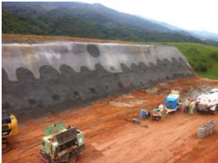
El concreto lanzado debe tener una consistencia relativamente seca para auto soportarse una vez colocado. El intervalo de relación agua – cemento utilizada se
