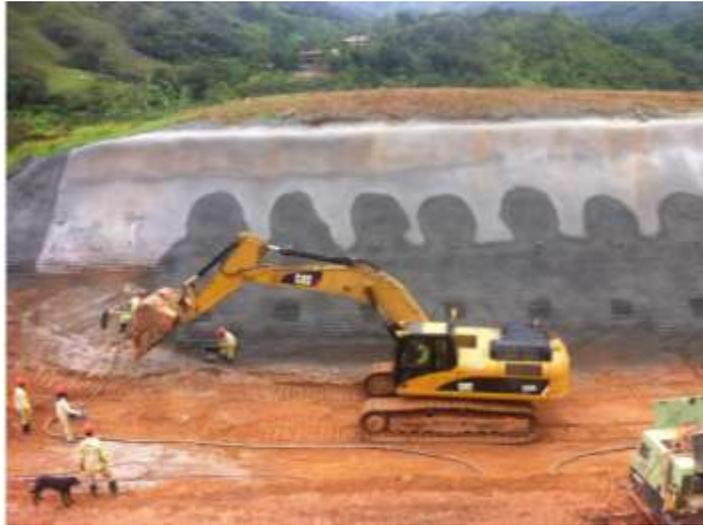
Se corre el riesgo que el concreto se atasque y endurezca antes de salir de la manguera, lo cual se debe controlar, regulando el tiempo estacionario del concreto dentro de la manguera, también es una práctica utilizada antes de comenzar el proceso de bombeo, preparar una lechada para lubricar la manguera y evitar taponamientos. En la vía húmeda es posible utilizar un mayor porcentaje de grava (40% por masa del agregado total) y con tamaños hasta de 12.5 mm (1/2”).
