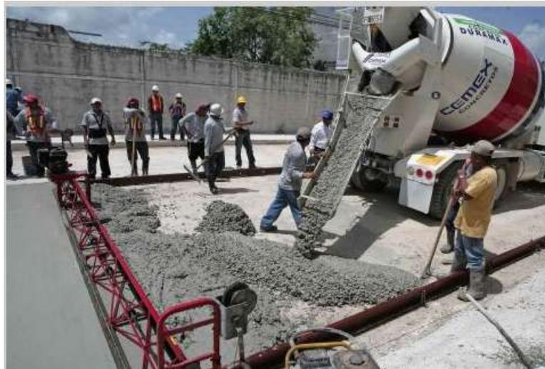
En la construcción de losas, la colocación deberá empezarse desde el perímetro, en un extremo, vaciando cada tanda contra el concreto colocado anteriormente. El concreto no debe vaciarse formando montones separados, nivelándolos y juntándolos después, tampoco se debe vaciar formando grandes montones, llevándolo luego a su posición final.
