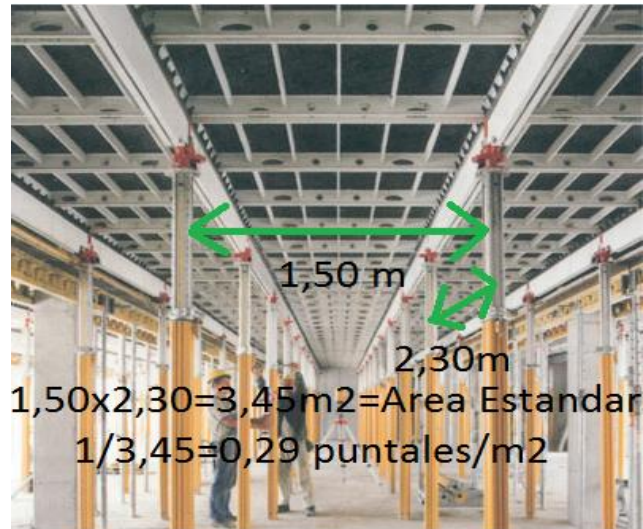
35. Espaciamiento sugerido en un sistema de encofrado de losas por un proveedor mundialmente conocido.
