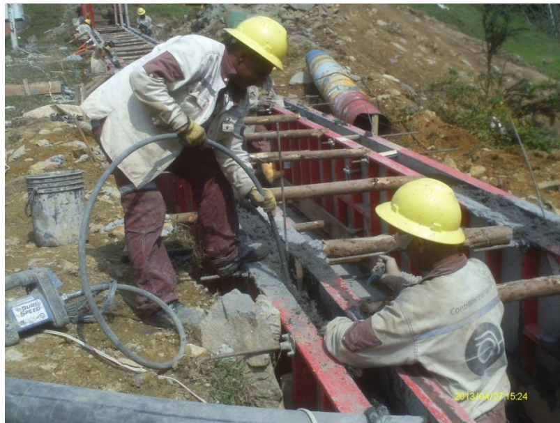
17. Vibrado realiza en obra.
