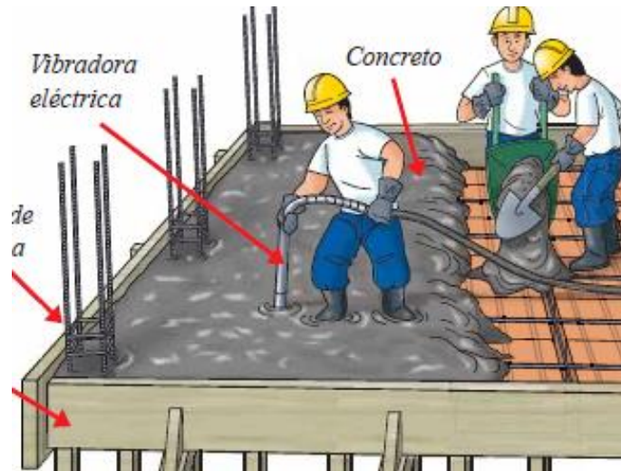
41. Vaciado de losas "Imagen extraída del manual del maestro constructor aceros Arequipa: Vaciado y compactado de concreto".
