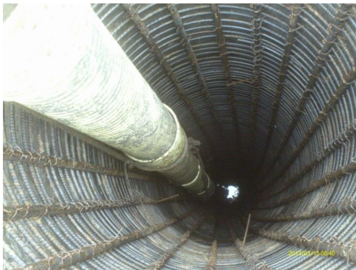
8. Construcción de la tubería de impulsión Ayurá - el Chocho vaciado de pila
