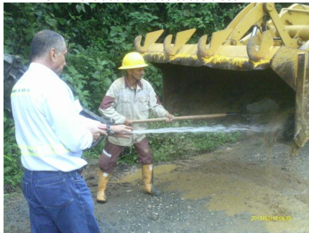
6. Limpieza en maquinaria para transporte de concreto
