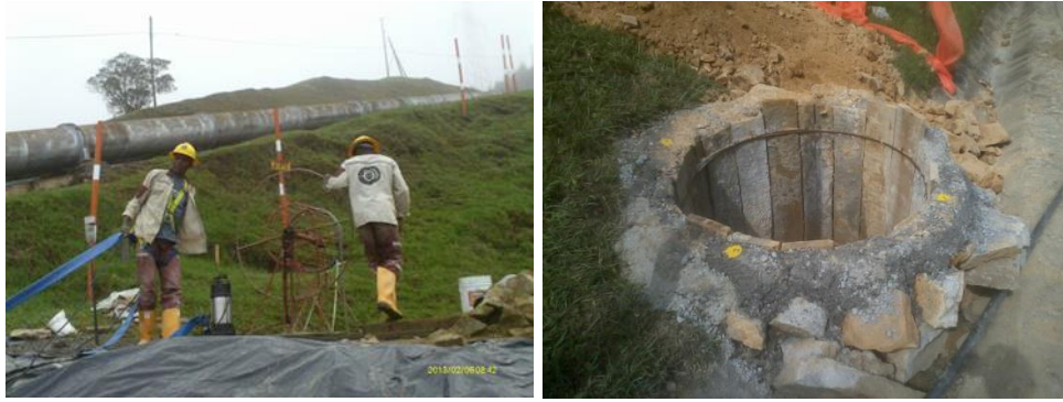
22. Manejo de aguas en obra
