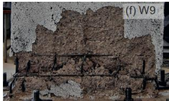
Fotografía 5-9. Vista frontal de la falla – Muro 9, adaptada de [3].
