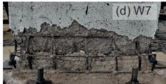
Fotografía 5-7. Vista frontal de la falla – Muro 7, adaptada de [3].
