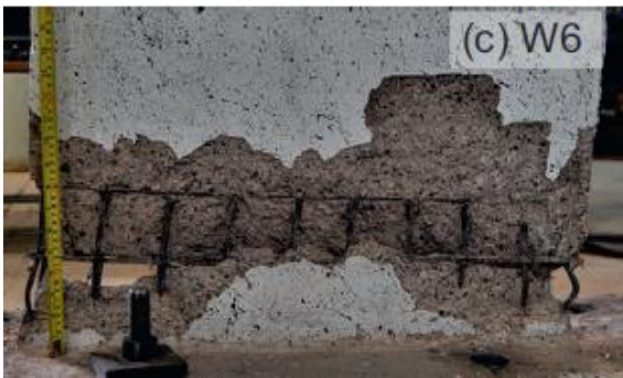
Fotografía 5-6. Vista frontal de la falla – Muro 6, adaptada de [3].
