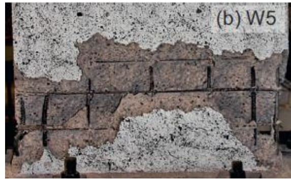
Fotografía 5-5 Vista frontal de la falla – Muro 5, adaptada de [3].
