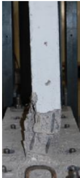
Fotografía 5-3. Pandeo del muro fuera del plano, adaptada de [2].
