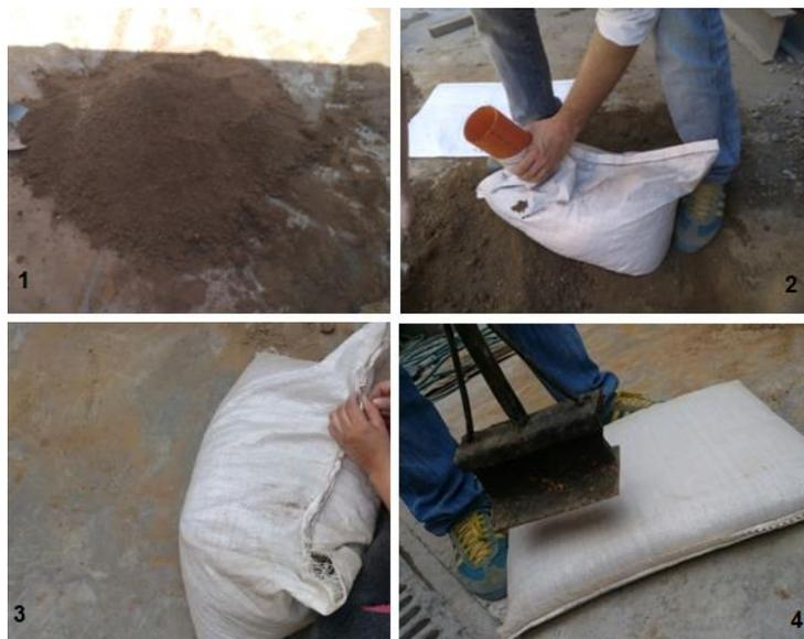
Figura 29. Proceso de conformación de sacos de suelo-cemento. Fuente: Elaboración propia.
