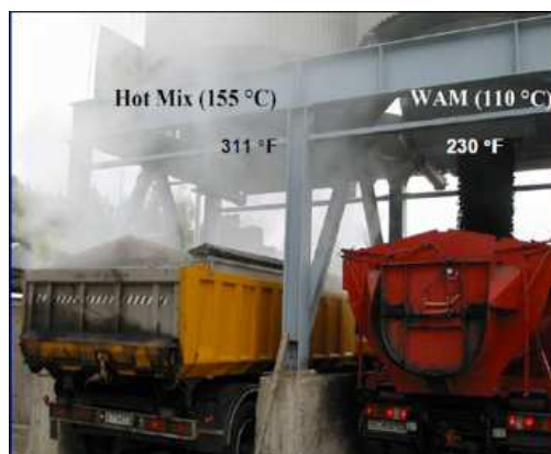
Figura 6.2. Prueba de comprobación en la descarga de mezclas asfálticas
