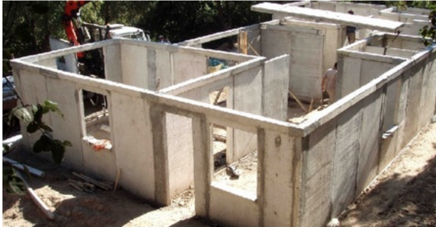
Imagen 35. Proceso de armado
