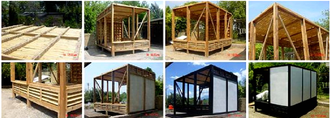
Imagen 81. Proceso de construcción
