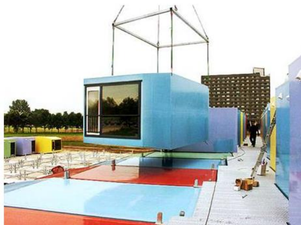
Imagen 40. Transporte de módulos
