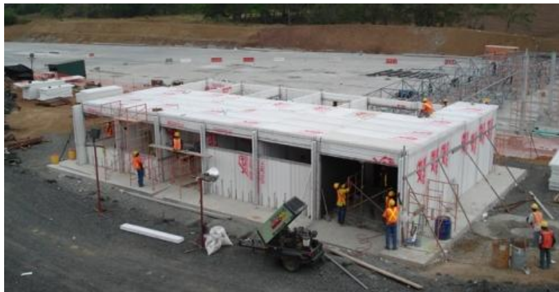
Imagen 22. Proceso de montaje
