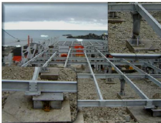
Imagen 61. Sobre emparrillado metálico
