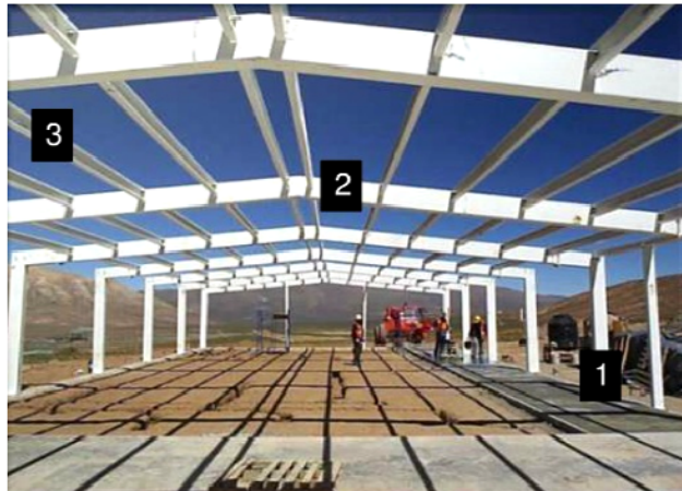
Imagen 63. Colocación de columnas
