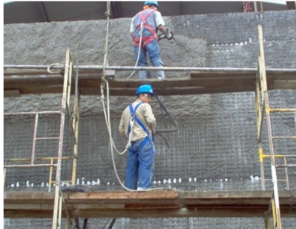
Imagen 13. Proceso de revoque
