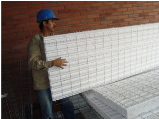
Imagen 11. Transporte del panel
