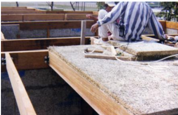
Imagen 15. Montaje de cubierta
