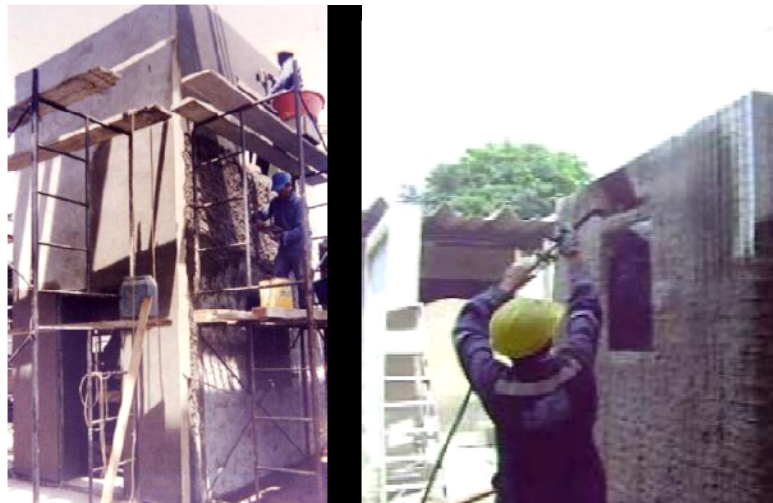
Imagen 29. Lanzadora neumática de mortero
