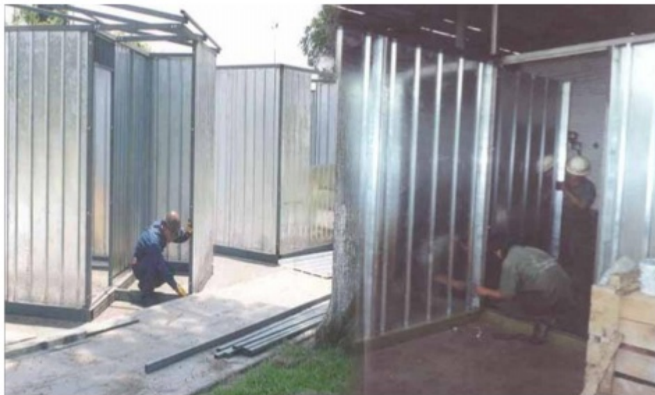
Imagen 88. Montaje de la vivienda
