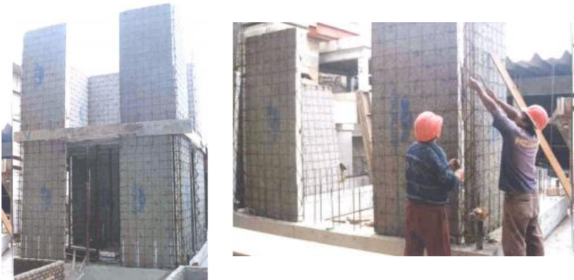
Imagen 27. Proceso de construcción
