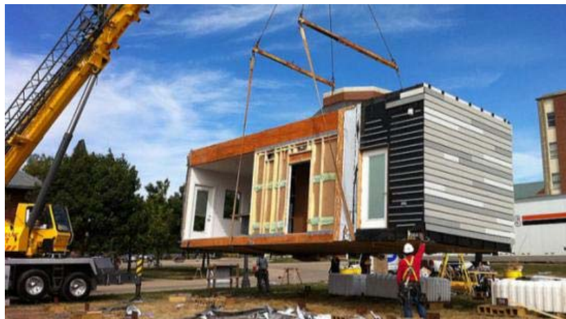
Imagen 48. Transporte de módulos
