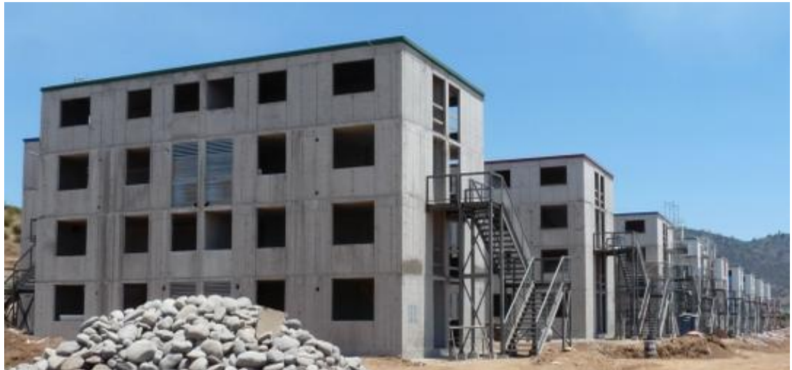
Imagen 87. Fachada de la urbanización
