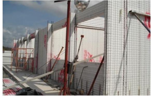
Imagen 24. Vista lateral derecha
