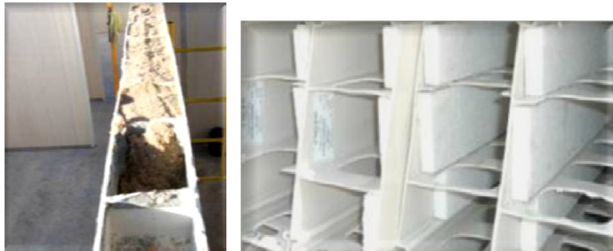
Imagen 66. Detalle de relleno
