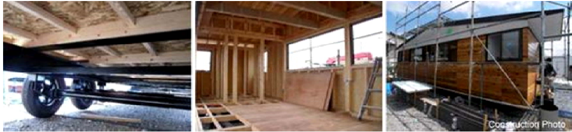
Imagen 85. Proceso de construcción y montaje
