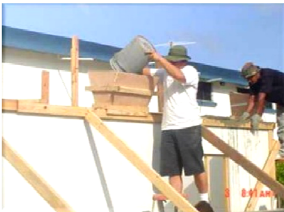
Imagen 65. Relleno y acabado de muros
