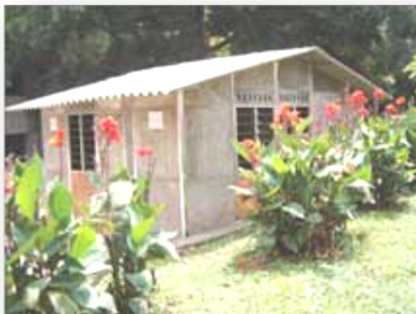
Fotografía 6. Vivienda prefabricada construida con paneles de concreto reciclado. Medellín, Antioquia. Fuente (Bedoya, S.f.)
