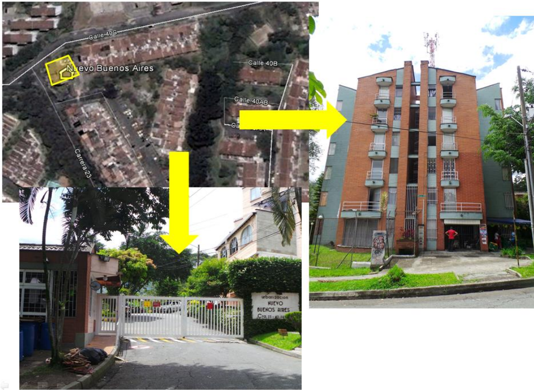
Fotografía 14. Aspectos generales de la Urbanización Nuevo Buenos Aires Fuente: elaboración propia
