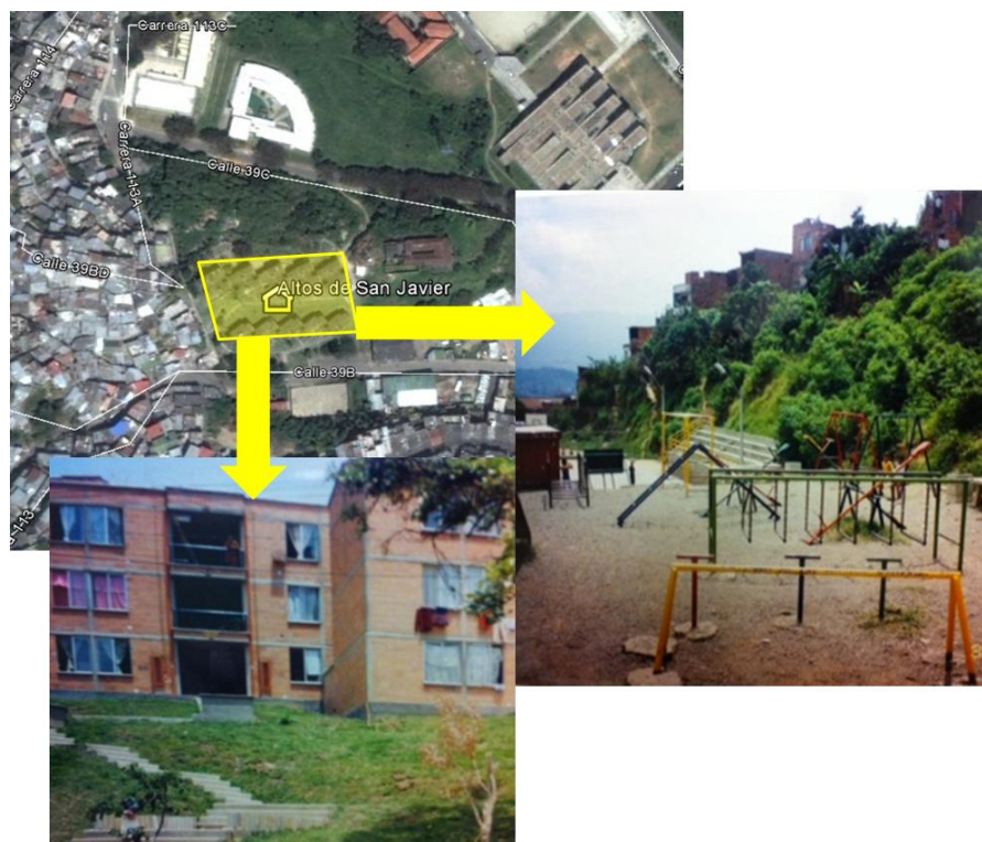
Fotografía 13. Ubicación urbana y algunas características del Conjunto Altos de San Javier una vez terminado Fuente: Elaboración propia
