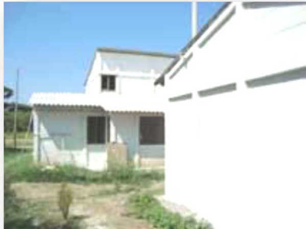
Fotografía 8. VISS construida con eco-materiales; aprovechamiento de cenizas volantes, escoria de hornos siderúrgicos, cerámicas descartadas para conducciones eléctricas. Palmira, Valle del Cauca. Fuente (Bedoya, S.f.)
