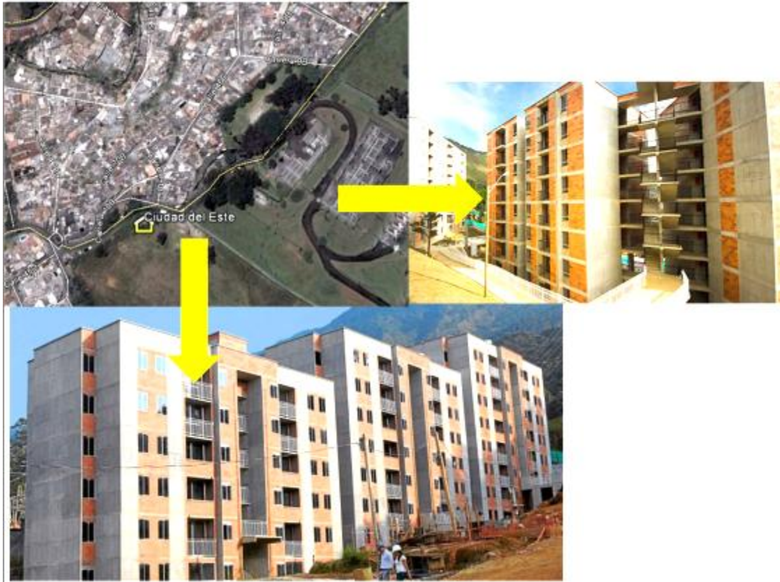
Fotografía 17. Ubicación urbana y exteriores del Proyecto Ciudad del Este durante su construcción
