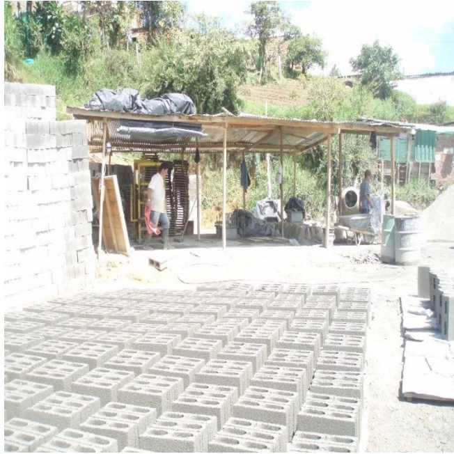
Imagen 12. Bloquera en obra 2.
