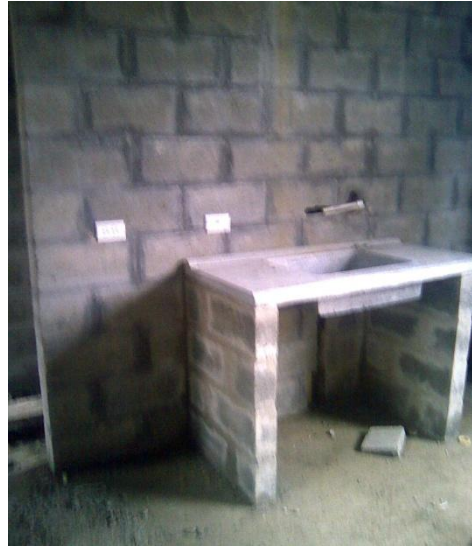
Imagen 6. Construcción de vivienda en bloque.
