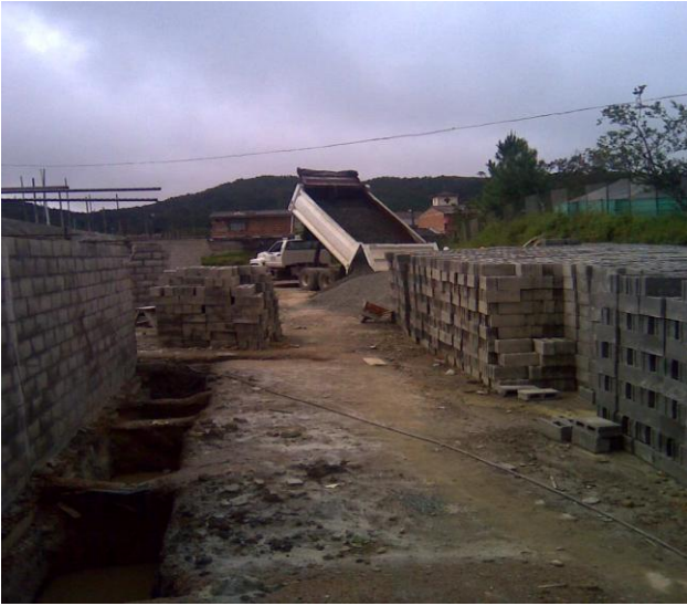
Imagen 5. Construcción de vivienda en bloque.
