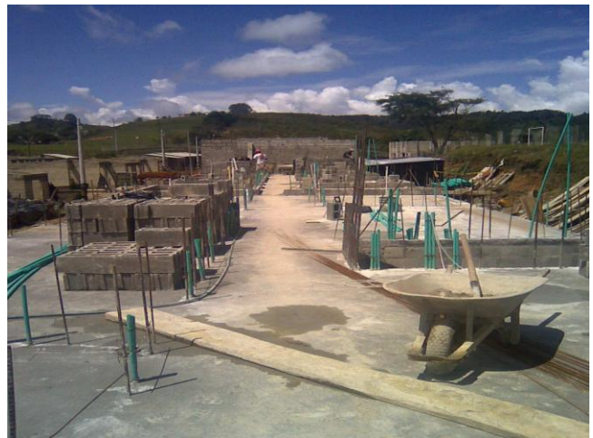
Imagen 4. Construcción de vivienda en bloque.
