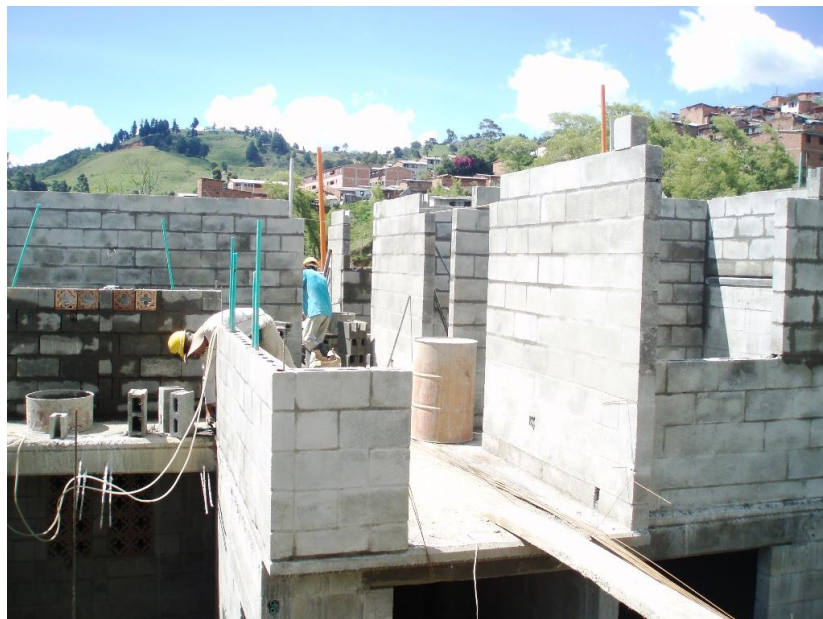
Imagen 13. Construcción de vivienda de interés social.
