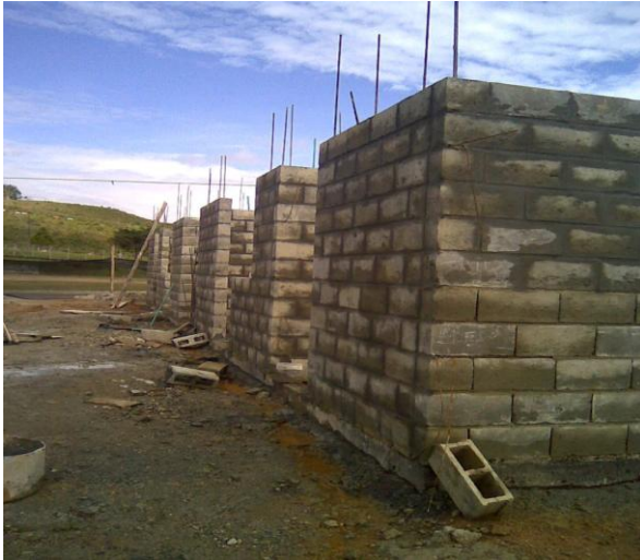
Imagen 1. Construcción de vivienda en bloque.
