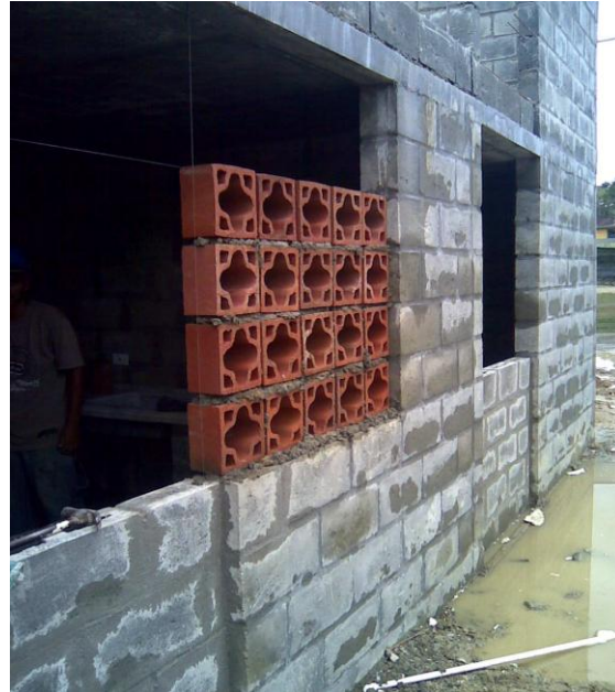
Imagen 10. Construcción de vivienda en bloque.
