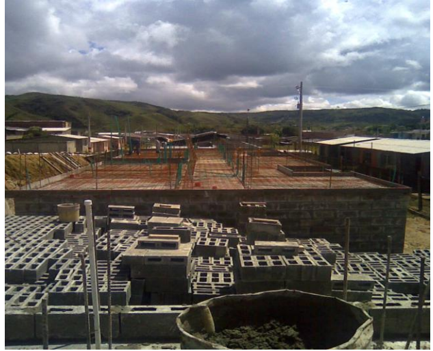
Imagen 2. Construcción de vivienda en bloque.
