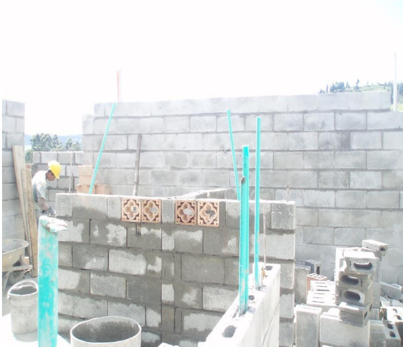
Imagen 14. Construcción de vivienda de interés social.
