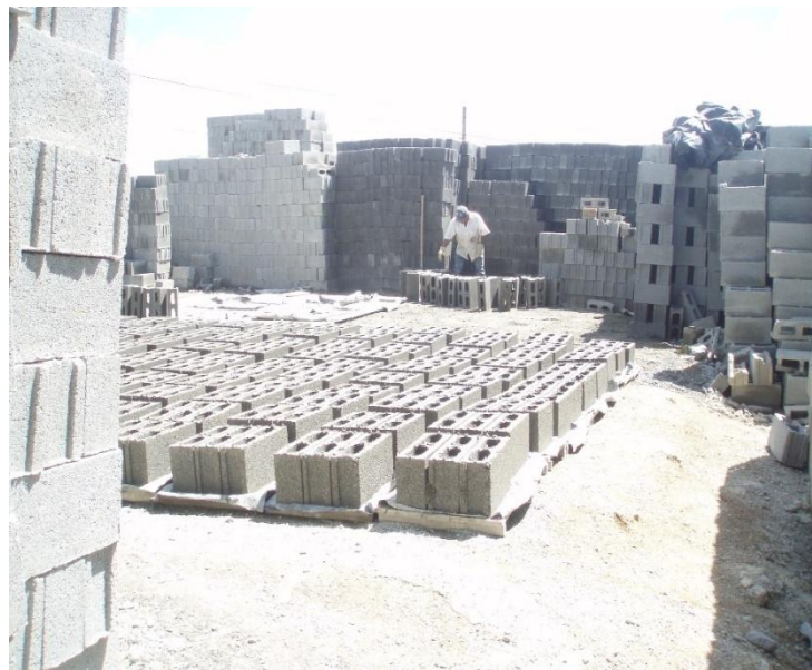
Imagen 11. Bloquera en obra.
