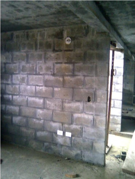
Imagen 9. Construcción de vivienda en bloque.
