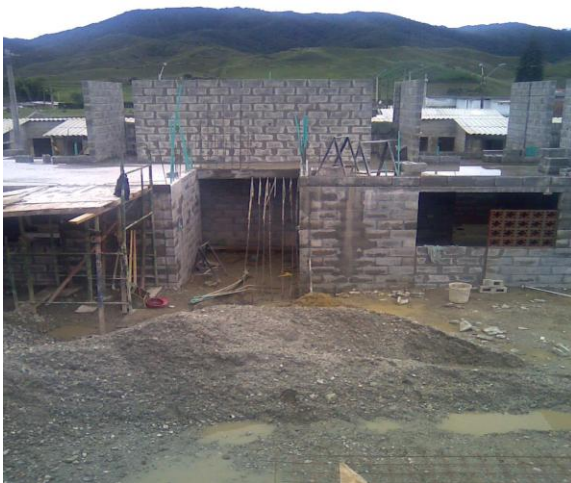
Imagen 3. Construcción de vivienda en bloque.
