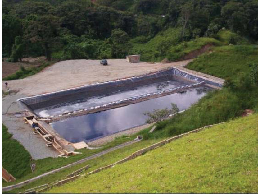
Ilustración 1. Lagunas existentes para el tratamiento de lixiviado en el relleno sanitario La Pradera.
