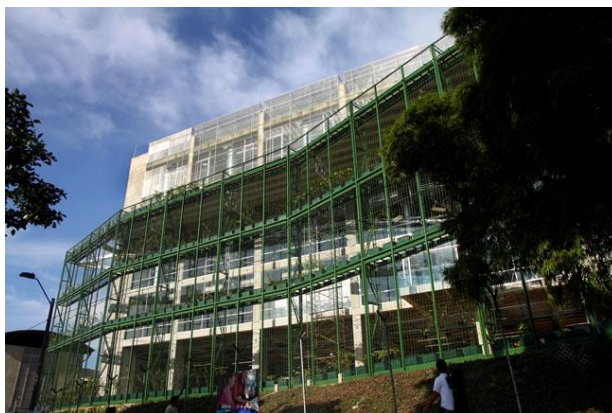
Figura 1: Edificio de Ingenierías de la Universidad EAFIT (El Espectador, 2010)
