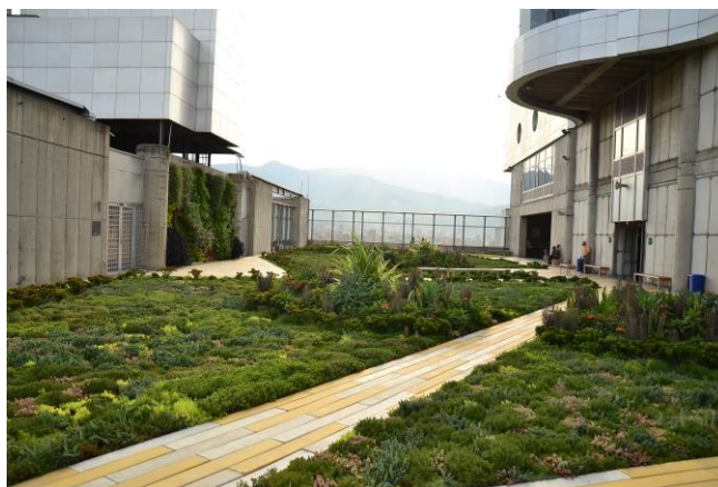
Figura 6: Terraza Verde – Edificio EPM, Medellín – Antioquia (Groncol, 2021)
