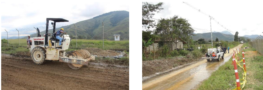
Figura 2.4 a) Compactación de la mezcla. b) Riego curado Fuente: Elaboración propia
