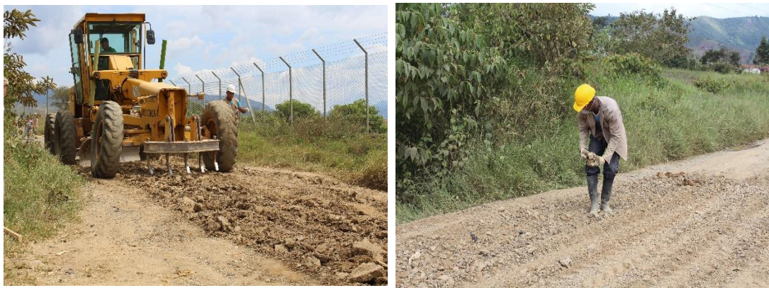
Figura 2.2 a) Escarificación del suelo. b) Retiro manual de sobretamaños Fuente: Elaboración propia
